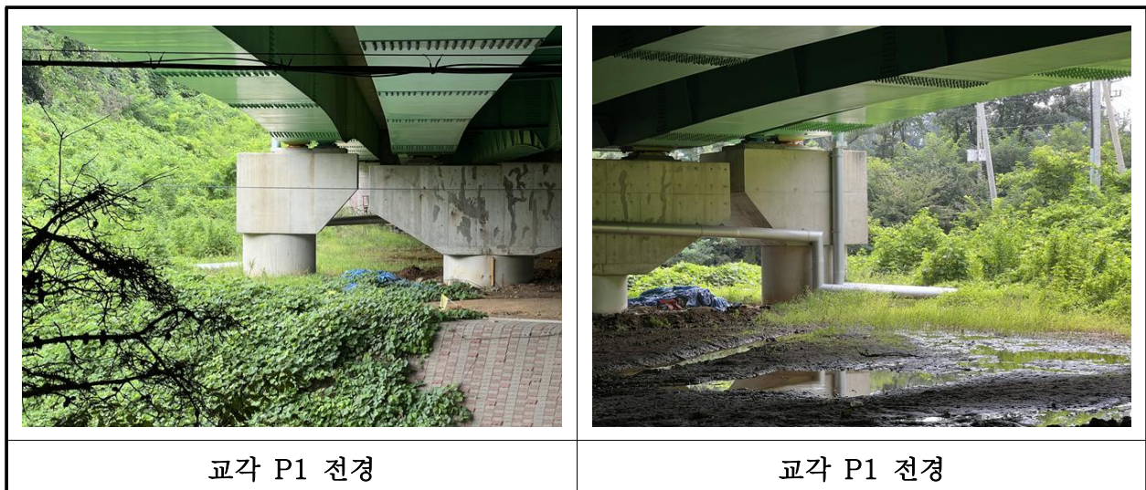
【사진 25.3.8】 교각 전경
