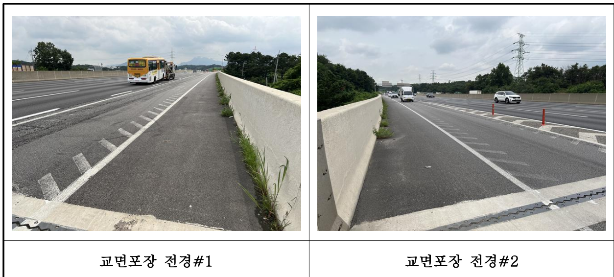
【사진 25.3.17】 교면포장 전경
