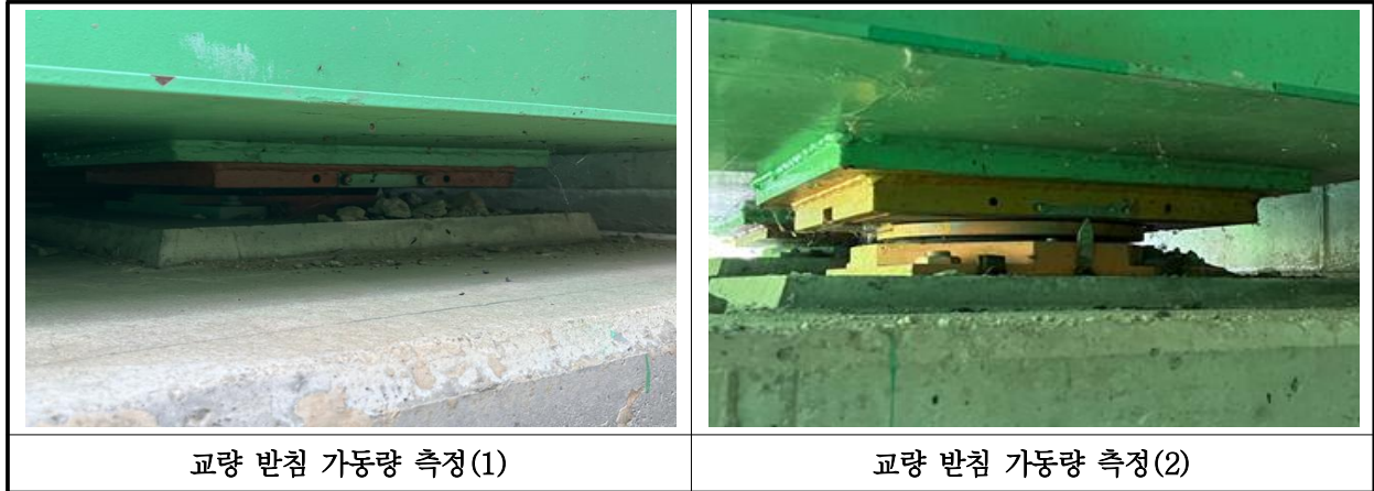
【사진 25.3.13】 교량받침 이동량 측정
