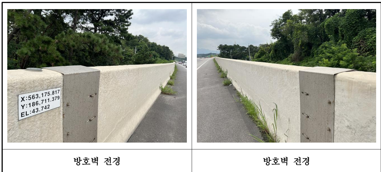
【사진 25.3.21】 방호벽 전경
