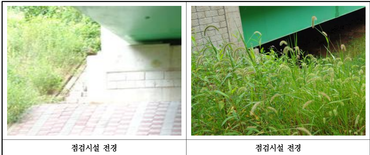
【사진 25.3.23】 교량 점검시설 전경
