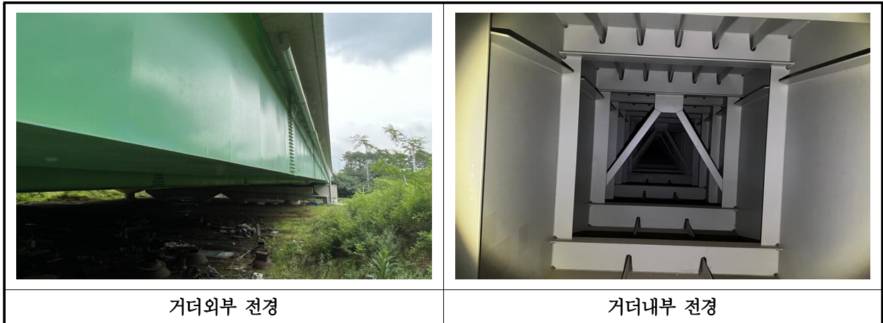
【사진 25.3.4】 거더 전경
