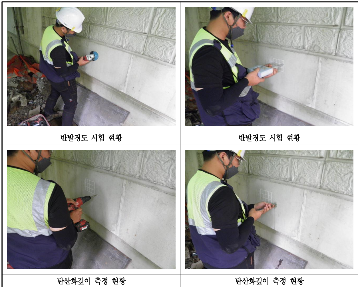
【사진 25.4.1】 콘크리트 내구성조사 현황
