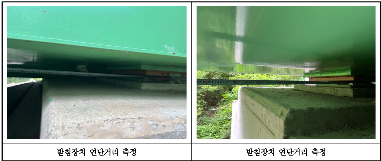
【사진 25.3.12】 교량받침장치 연단거리측정
