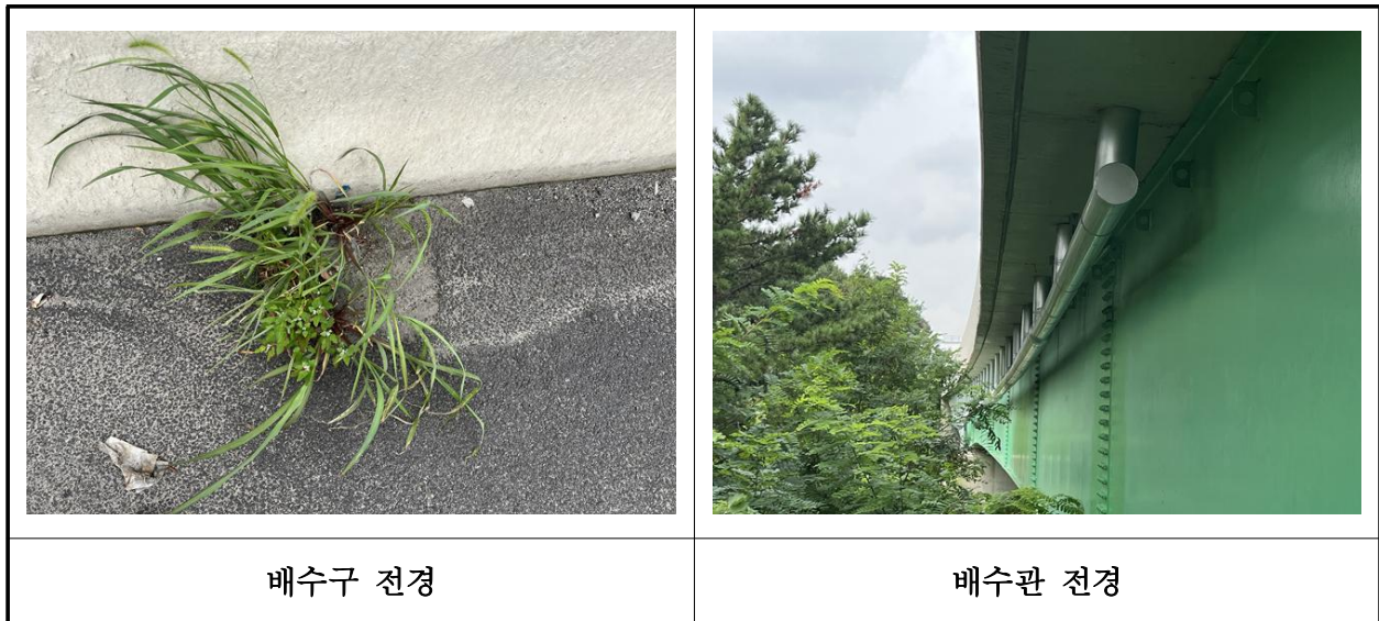
【사진 25.3.19】 배수시설 전경
